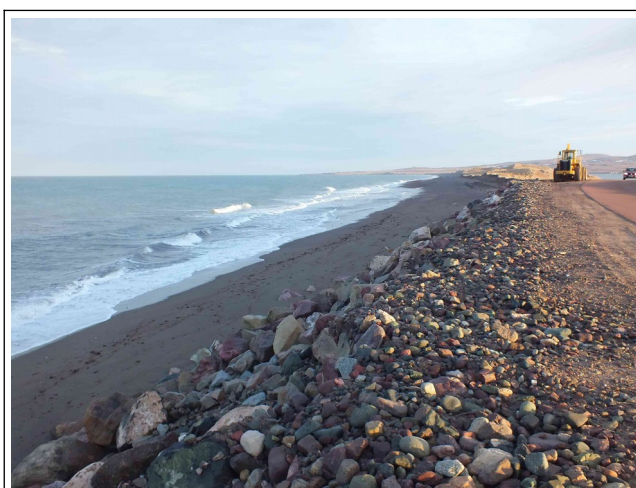
Allongement de la plage vers le sud en cours
