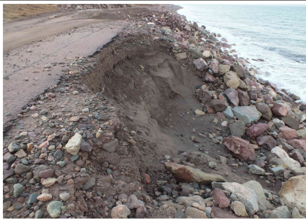
Reprofilage de talus de l'effondrement avant la plateforme de stockage
