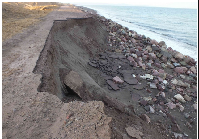
Reprofilage de talus de l'effondrement aval
