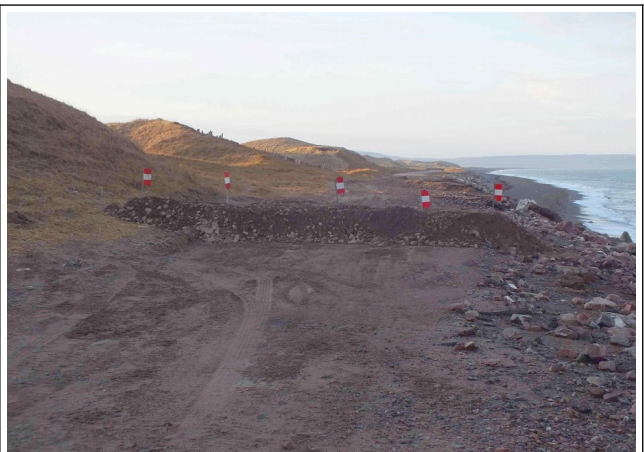
Merlon de fermeture de la chaussée
