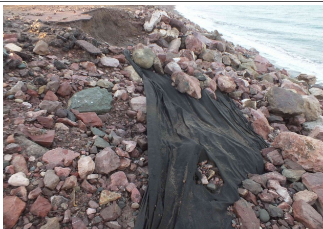
Etat du blocage sur l'effondrement du 26 février (zone de stockage)
